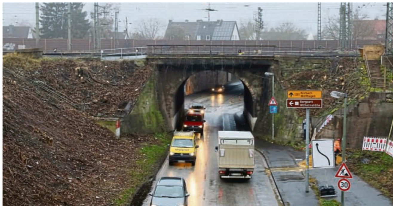
Nadelöhr an der Wolfhager Straße: Die Bahn will für 40 Millionen Euro die veralteten Überführungen in diesem Bereich erneuern. Die Arbeiten werden voraussichtlich bis Ende 2024 dauern.
