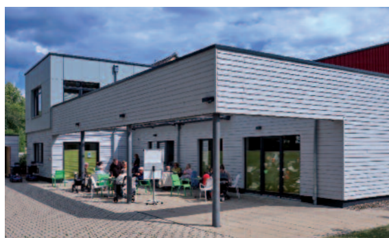
Aufstockung Gebäude Kinderschutzbund
